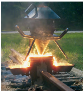
El hierro fundido que se forma en una reacción termita es descargado en un molde entre los dos extremos de unas vías. Al enfriarse, los rieles quedan soldados.
