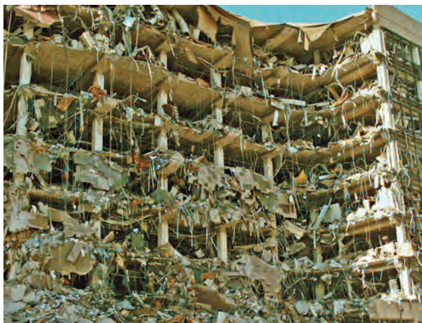
El edificio Alfred P. Murrah después de la fatal explosión ocasionada por una bomba de nitrato de amonio.
