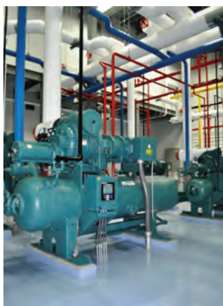
Sistema de refrigeración de amoníaco industrial.
