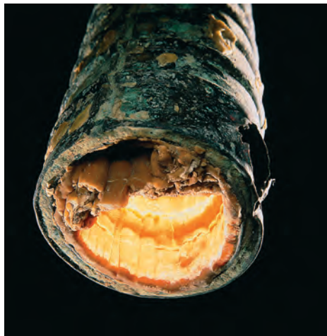
Los depósitos de los calentadores casi obstruyen por completo esta tubería de agua caliente. Estos depósitos están compuestos en su mayor parte por \text{CaCO}_3 y un poco de \text{MgCO}_3 .
